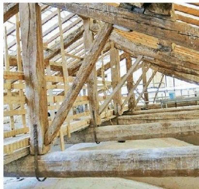
Nella foto di Gianni Bellesia, i lavori in corso alla chiesa di Moglia
