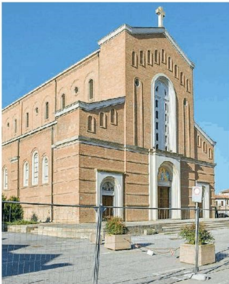
La chiesa parrocchiale transennata per i lavori NICOLA SACCANI
